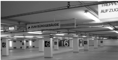
Abb. 0.3: Parkhaus im Leerzustand (Frankfurt a.M.)
